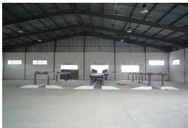
Centre de tri sur le site du CET de Tebessa
